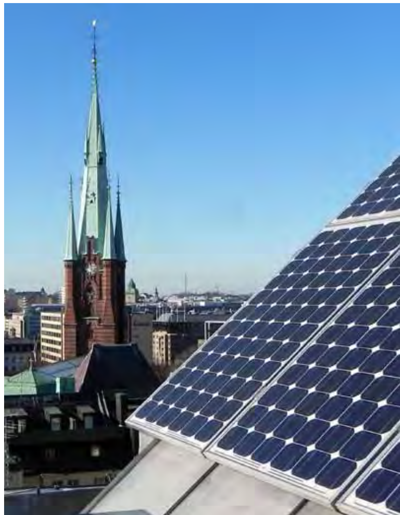
Solcellsanläggning på Kulturhusets tak. Foto: Lovisa Lagerblad/Länsstyrelsen.
