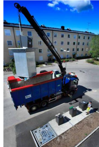
Tömning av PWS underjordsbehållare med kranbil.
