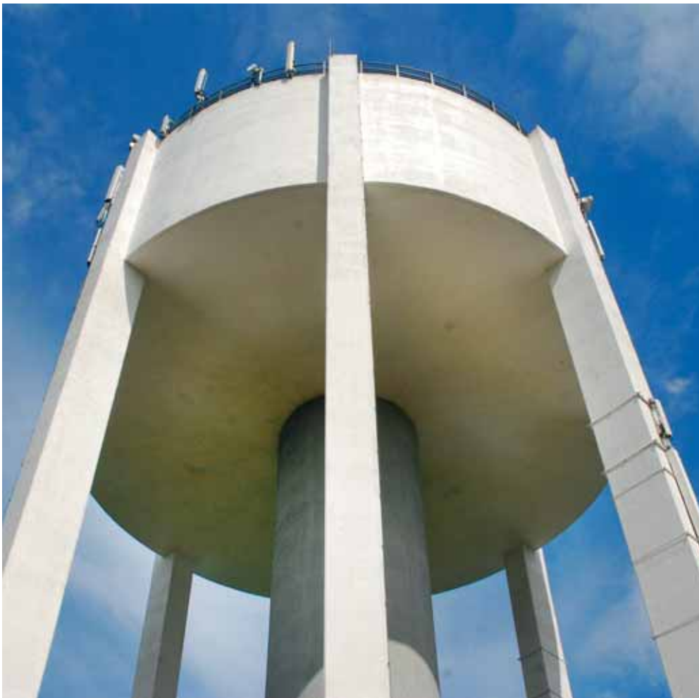
Gustavsbergs vattentorn. Foto Kenneth Norberg
