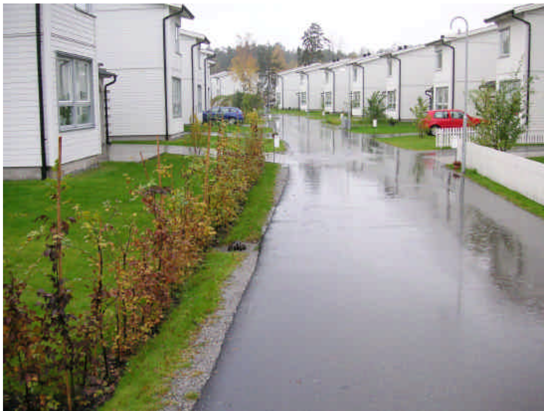
Bostadsgata utan kantsten eller gatubrunnar. Avrinning sker till ett poröst svackdike vid sidan av gatan, vilket försetts med dräneringsledning i botten och med brädd via kupolsilsbrunn. Kantstenen har ersatts av en stödremsa. Det inskjutna fotot visar ett svackdike mellan gata och trottoar. Foto: WRS Uppsala AB
