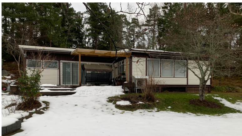
Figur 30. Referens: befintligt fritidshus i Kopparmora.
