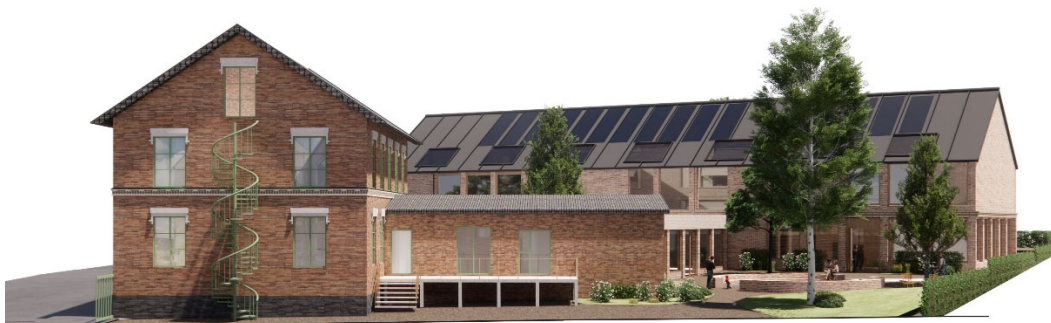
Fasad mot öster mot personalparkeringen. Till höger syns en häck som ska planteras mot angränsande bostadstomt i norr och som hindrar insyn från församlingsgården.
