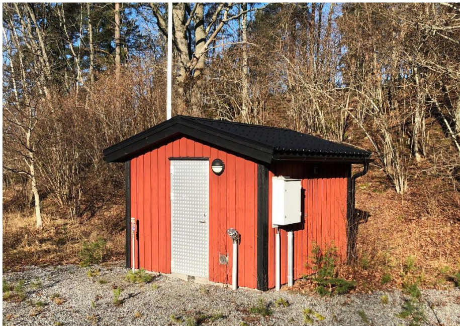
Figur 21. Bild som visar ett exempel på hur pumpstationer kan utformas i Värmdö kommun.
